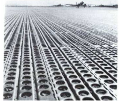
Flygplatsens start- och landningsbanor i Seoul var märkliga. Man hade lagt ut stora perforerade järnmattor.
