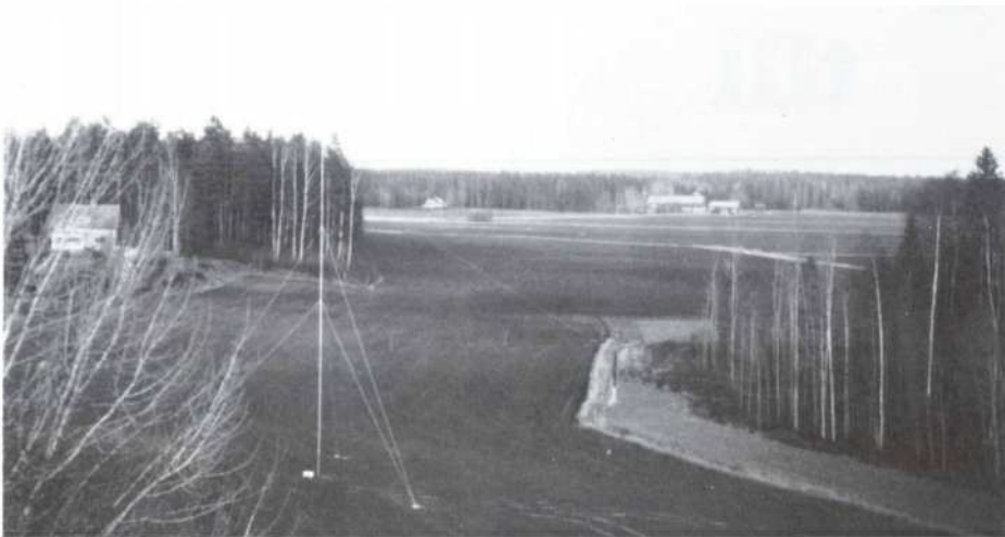
En vacker syn efter många dagars arbete. Bilden visar vertikalen för 160 m och Beverage antennen mot VK (vita strecket)
