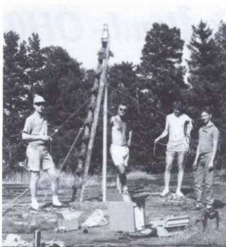
Den teleskopiska masten för 3-element-aren på plats. Efter det att antennen monterats, skickades den upp till 10 meters höjd över berget. Denna manuell mast ersattes det senaste året av en tryckluftdriven. Från vänster, SM0JV, SM0HJZ, SM0GNS och SM0IHR.
