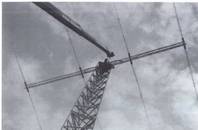
Här åker den ca. 50 kilo tunga antennen 22 meter upp i luften.
