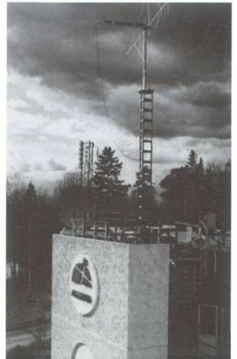
En 9 elements yagi-antenn för 2 m i toppen på en roterbar mast. Toppöret är av plast och matarkabeln går vinkelrät mot bommen för att inte påverka strålningsdiagrammet. I bakgrunden syns masten med sändarantennerna.
