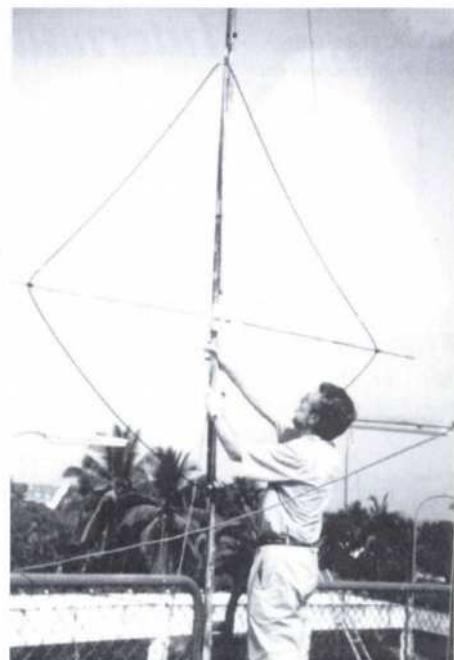
Erik försöker öka mottagningen på 160 meter mot allt QRM/QRN med en loop-antenn!
