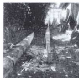
Mastbygge, tre trädstammar skarvas tillsammans till 50 meters trämast...
