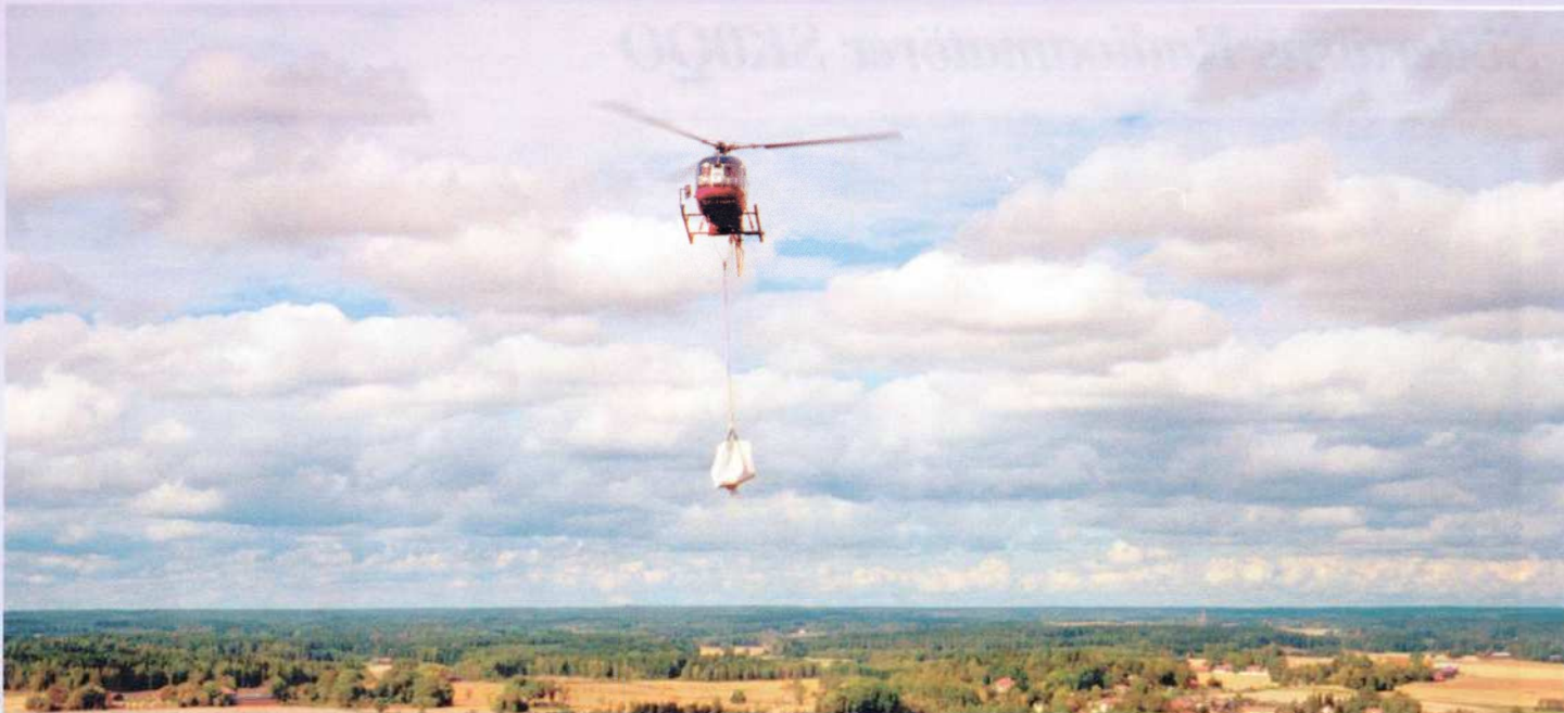
Sörmland från vårt antenn-QTH. Här i säcken transporteras gummimattor, för taktäckning; gasol, för svetsning av gummimattor, koaxkabel, rotor, nyspikade fönsterkarmar m.m. Totalt gjordes fem lyft.
