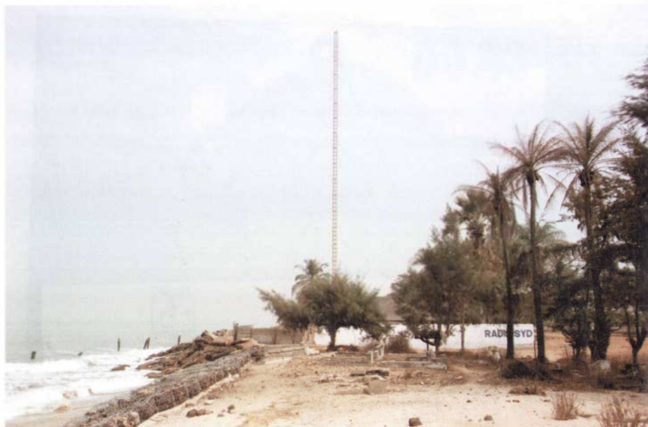
Antennmasten står idag bara några meter från havet.
