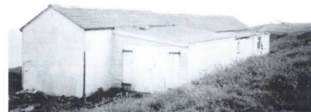
Lizard Wireless Stationen sedd från baksidan som den såg ut år 1999, innan ombyggnaden. Foto SM6NM/LARS
