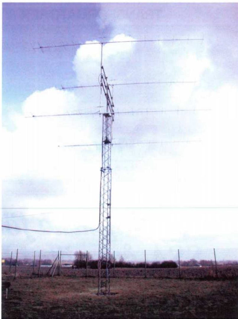
SK7MW:s nya EME antenn, 4 x 17 element. Foto: SM7MRL Ingvar
