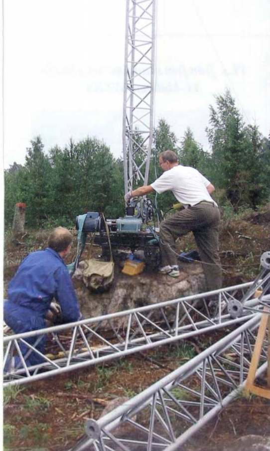
Här jobbas hårt med att sätta upp 42 ån med på bild är SM5IMO och Bengt (klättrare)
