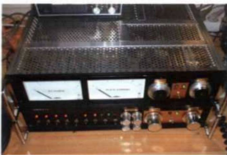
SM4XTF Rolfs slutsteg för 10m. Ett precisionsbygge - DY (hembbygge) - som nu hittat ända upp till toppstugan i Sunne. Slutsteget är byggt på EL519 och ger som mest drygt 1,2 kW PEP.
