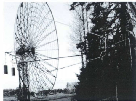
SM2CEW Peters månstuds parabol på hela 8 m i diameter. 2m beamar Här i viloläge-serviceläge
