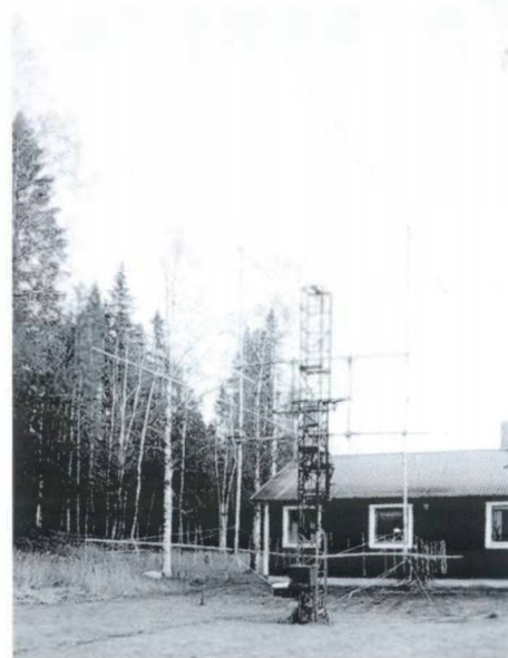
SM2CEW Peters anläggning och QTH vid Persön, norr om Luleå. 2-meters beamar i nedhissat läge = serviceläge.
