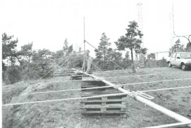
Den senaste tillskottet till Stures OH0JFP antennfarm. En 10-elementare för 6 meter som blir en del av en större anläggning med 4 sådana antenner.
