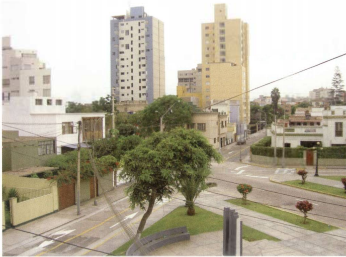
Elledningar i Miraflores.
