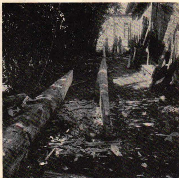
Hopskarvning av antennmast
