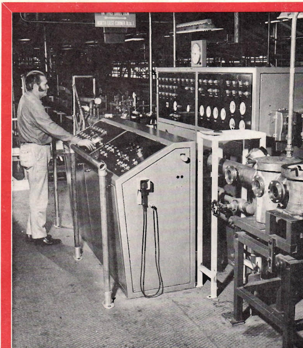
Fig 2. Här gjuts polyetenisoleringen runt koaxialkabelns kärna. Kabellängder upp till 33 km kan göras utan skarvar. I apparaturen ingår övervakningskretsar som mäter diameter och kabelns rundhet. Korrigeringar sker automatiskt.
