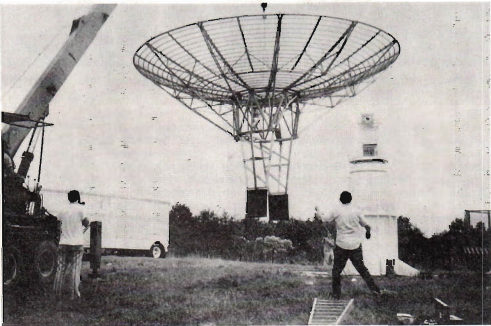
Fig 4. 9 m-parabolantennen under montering på sitt fundament. Den användes för mottagning av mikrovågssignaler från månfarkosten.
