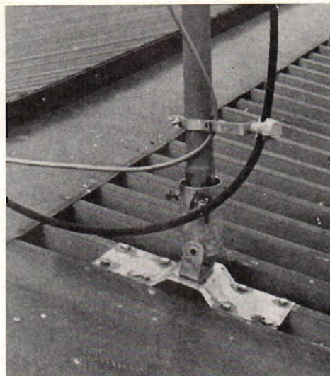
Fig 3. Masfot placerad på taket. Fästet kan även bockas så att det i stället placeras på takåsen.
