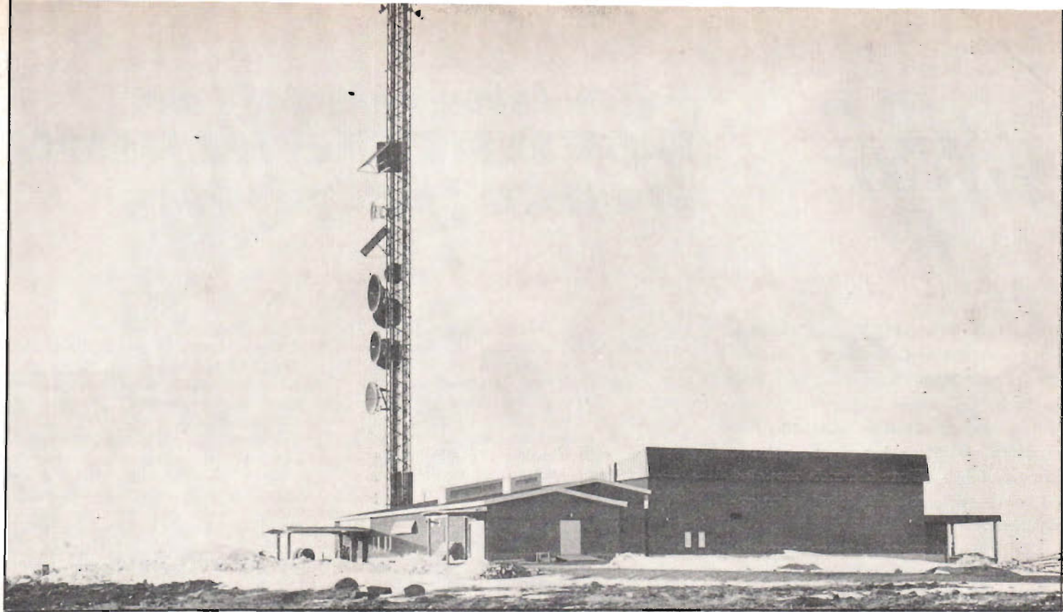
Fig 1. En modern svensk sändaranläggning (Gällivare-stationen) med antensystemen monterade på olika nivåer över marken. Märk parabolerna riktade åt vänster i bilden. Antennmasten stagas på olika höjder och skall kunna motstå mycket höga vindstyrkor. (Foto Televerkets centralförvaltning).
