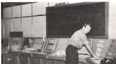
Fig 3. Här en interiör från Tryvannstornet, Norges motsvarighet till RRC S. Den stora "ställverkstablån" på bilden är display i det datoriserade övervakningssystemet för alla distributionsvägar och sändare.
