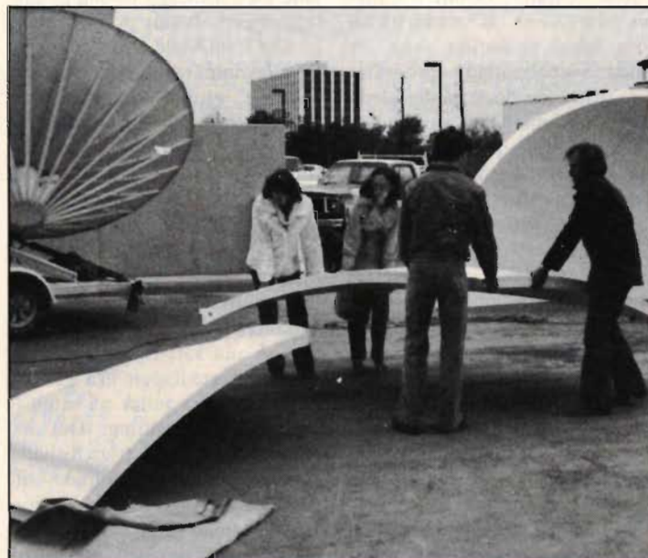
Fig 7. Stora parabolor blir naturligtvis svåra att frakta, inte minst med tanke på att mycket små deformationer kan ödelägga hela funktionen. Här ser vi en lösning av problemet. Antennen i bitar visades på SBOC-mässan härförleden.
