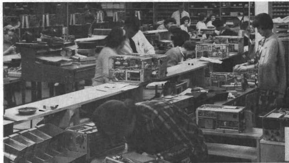
Fig 14. En glimt av tillverkningen av oscilloskop för militära ändamål. I monteringen, som ses här, är som i andra delar av denna elektronikindustri många kvinnor sysselsatta.
