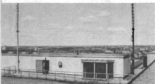
Fig 6. Sändarantennerna utgöres av flera små kvartvågselement kopplade till halv-vågsantenn med förstärkningen 3 dB. De åtta översta elementen på vänstra masten utnyttjas för förbindelse med tb 1 och de åtta nedersta för tb 2. Den högra masten användes för busskommunikation.
