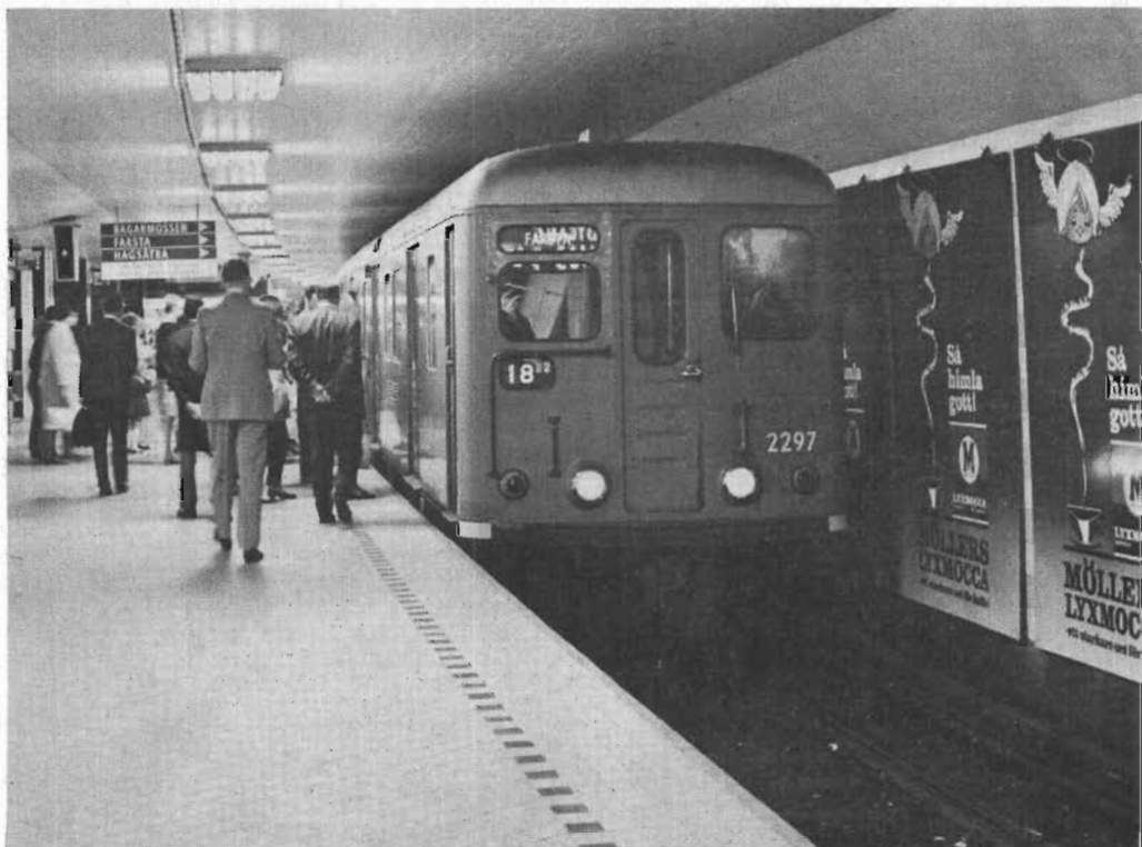
Fig 1. Bilden visar hur en av de balanserade transmissionsledningar, som utnyttjas som tunnelantenn, är arrangerad längs taket vid en hållplats. På tågets tak syns dessutom en skymt av den fenliknande tågantennen.
