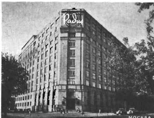
Radiohuset i Moskva är en solid, industriliknande byggnad, som synes.
