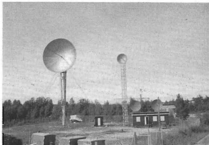
Fig 2. Mottagarstationen i Mora. Den stora antennen är placerad 20 m över marken och har 10 m diameter. För studium av den mottagna signalens fördelning i rummet är 3 m-parabolerna rörliga i vertikal och horisontal led.
