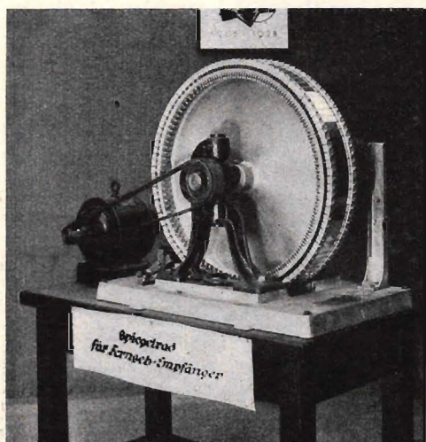
Fig. 2. Ett spegelhjul, av vilket en mindre typ användes i den i fig. 1 visade televisionsmottagaren.
