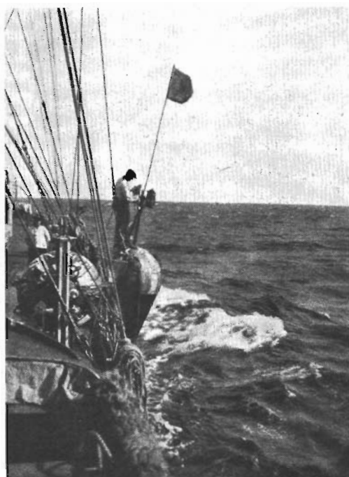
Kabelsträckan markeras före utläggningen med bojar på 6 å 8 sjömils avstånd.
