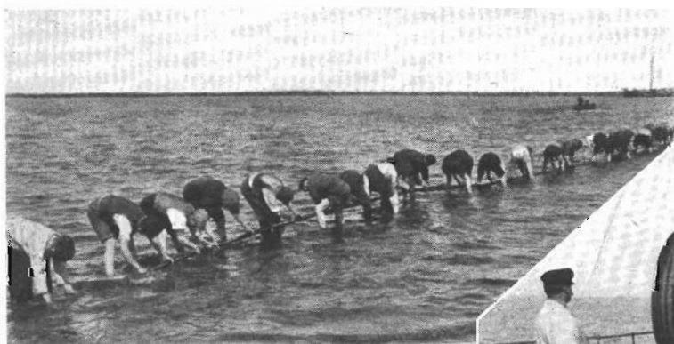
Kabeln drages fram över grunt vatten.
