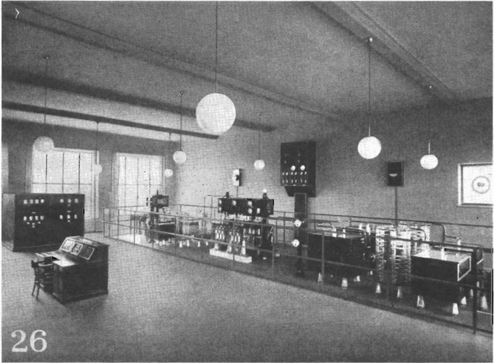
Fig. 1. Stora salen i den nya rundradiostationen i Prag. I mitten synes kontrollbordet och vid fönstren oscillator-modulator. Sedan är högfrekvensförstärkaren mycket schematiskt uppbyggd på golvet. Sista stegets stora vattenkylda rör synas i stativet mitt på bilden. Närmast till höger ligger effektkretsens spole och kondensator.
