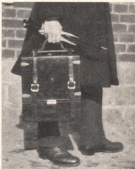
Fig. 1. De Forests transportabla 4-rörs reflexmottagare med hopfälld antenn.
