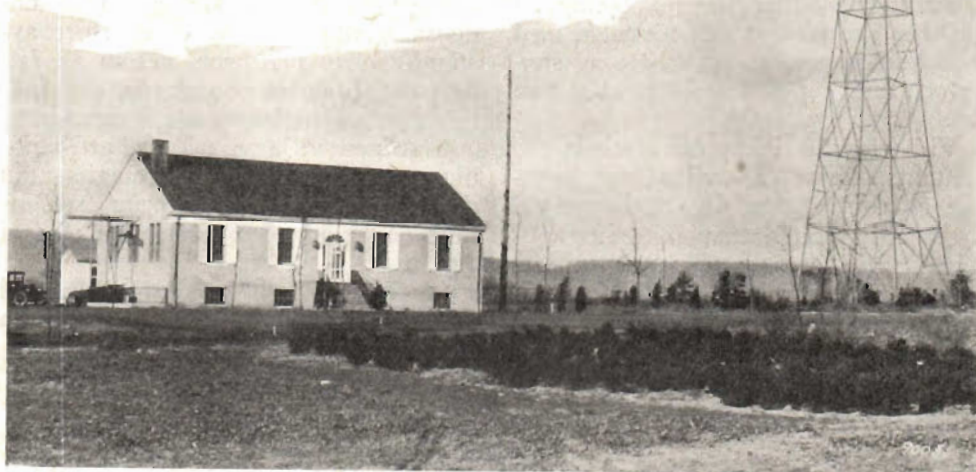
Fig. 1. Stationshuset med masten för 60-m-antennen och ena tornet för 454-m-antennen.
