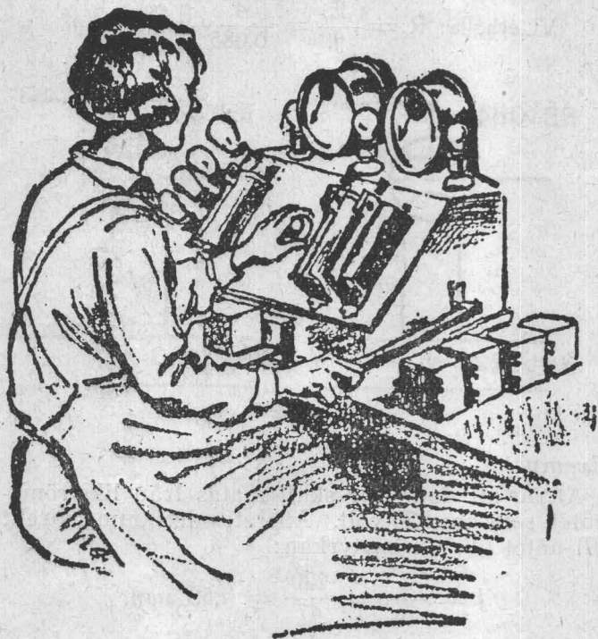
Alla detaljer måste underkastas en noggrann kontroll. Här undersöks blockkondensatorerna.
