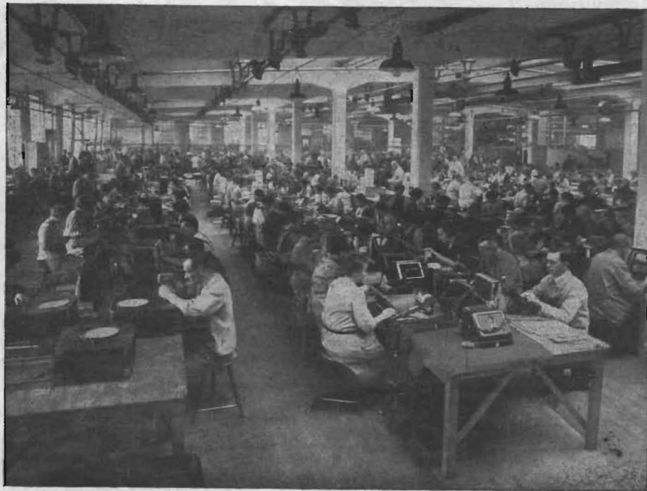
Fig. 2. Interiör av stora monteringshallen. T. v. se vi "tjugorna", t. h. "trettioåttorna".
