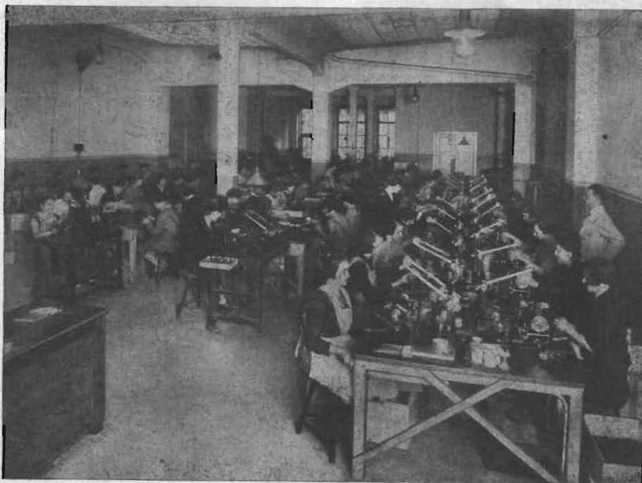
Fig. 3. På denna avdelning lindas spolarna, transformatorerna och drosselspolarna.
