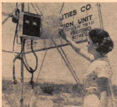
Manövertavla till vindelverk som skyddar vattenrör mot rost.
