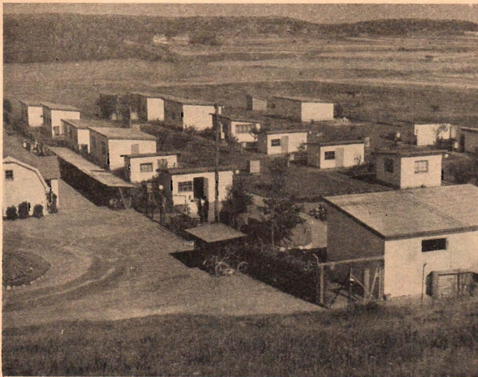
T. v. Vy över de bombsäkra paviljongerna, där den pyrotekniska materielen tillverkas. En del av paviljongerna ha ända upp till 80 cm tjocka väggar. Mittbilden: Företaget förfogar naturligtvis över en välutrustad mekanisk verkstad. Nederst: Denne bistre herre i stabil skyddskappa och dito huva är sysselsatt med ett allt annat än riskfritt jobb. Han håller nämligen på med påfyllning av sprängladdningar.
