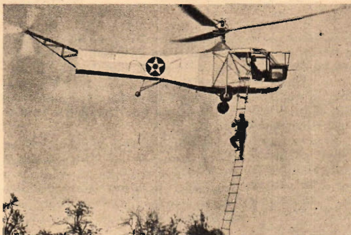
Denna helikopter, som användes inom den amerikanska armén, har konstruerats av Sikorsky. Dess huvudrotor är ungefär tio meter i diameter, medan styr-rotorn vid stjärten är något över två meter i diameter. Liksom sin mindre kollega kan den flyga i vilken riktning som helst, sålunda även rakt upp eller rakt ned.
