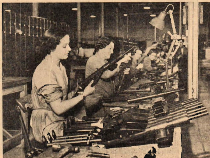
Ett nytt maskingevär under tillverkning för engelska hemvärnets räkning. Den har fått smeknamnet "Sten"-bössan och kostar c:a 40: — kr. pr. styck. Man kan skjuta dels helautomatiskt eld, dels patronvis eld med den nya bössan.
