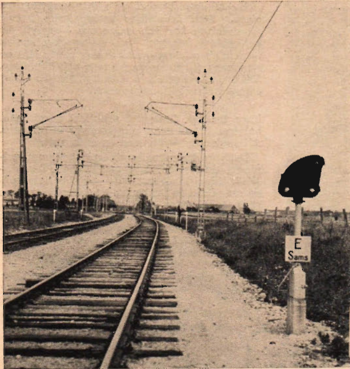
Dubbelspårig stambanelinje på SJ visas i fig. 1 ovan. T. h. ses modern dvärgsignal med konsolmontage.
