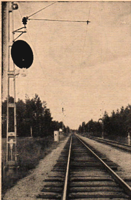
Ovan ses (fig. 1) en modern försignal monterad på ledningsstolpen vid en stambanelinje. Nedan återfinnes en huvudsignal (fig. 2) likaledes monterad på ledningsstolpe. Skala finnes angiven på figuren.
