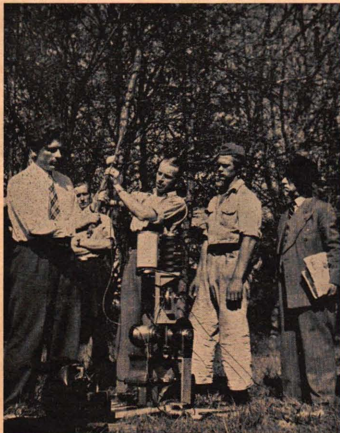
Ett studiebesök på Statens Geotekniska Institut som visade en borrustrustning i arbete i Lilljansskogen ingick också i nim 3.
