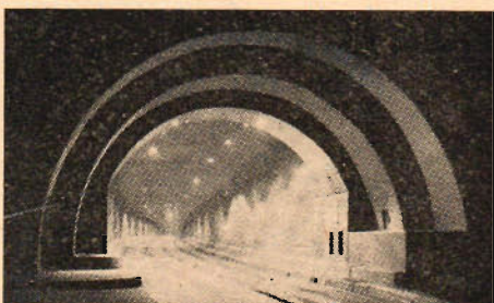
Det inre av en tunnel.
