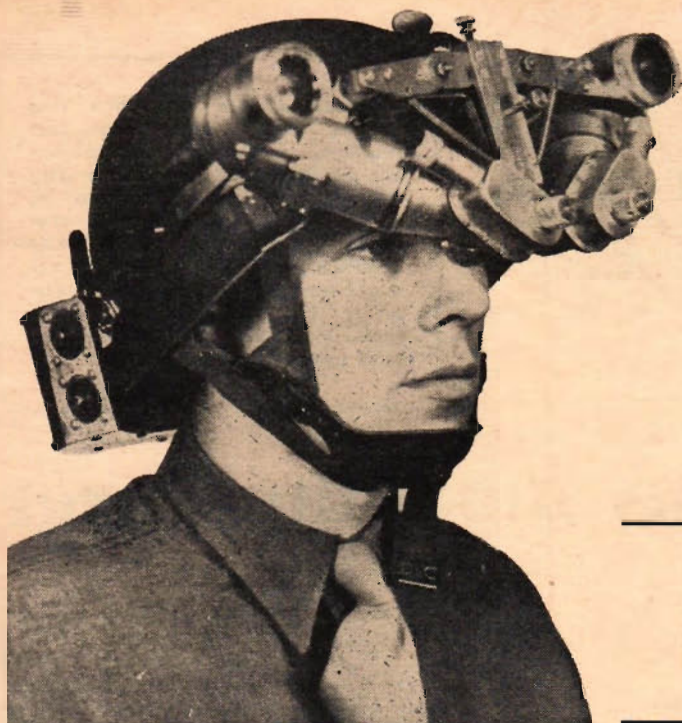
Amerikansk soldat med en tidig modell av "Snooper-scope", varigenom han i absolut mörker kan se flera hundra meter.
