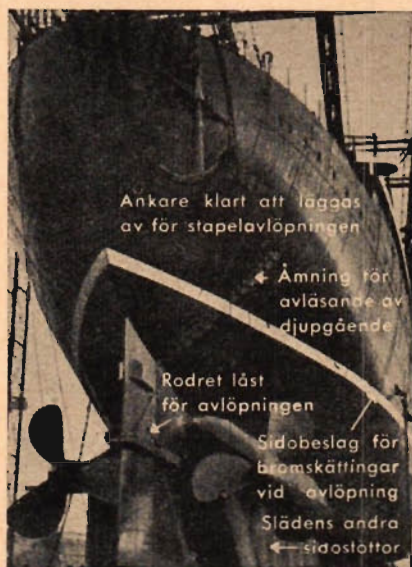
Vy över det färdiga akterskeppet.
