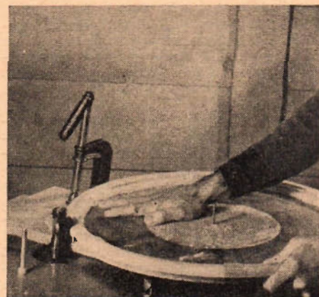
Profilen på brickans periferi fräses. Brickan centreras med en spik på arbetsbordet.
