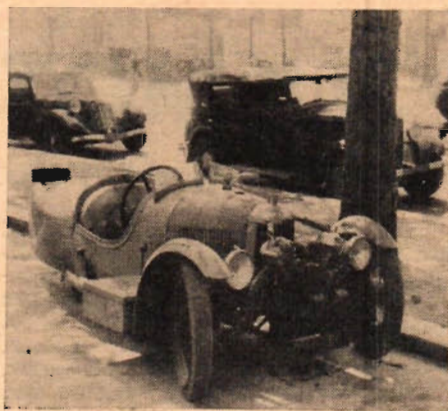
Den franska versionen av en hembyggd bil på Paris gator. Motorecykelmotorn sitter längst fram för att få luftkyllningen "gratis". Vagnen är försed med tre hjul.
