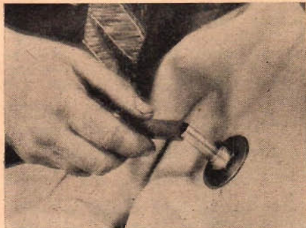
Nippeln monteras i botten på bassängen. Gummipackningar på båda sidor om duken.
