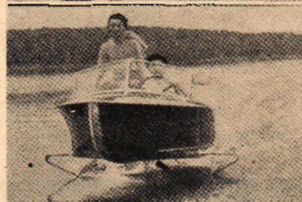
T. h. en av Tietjens bärplanbåtar i full fart, varvid stålbygeln bär upp båten helt och hållet.
