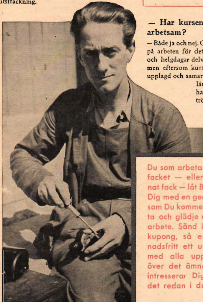
Erik Åsén sysselsatt med installationsarbetet i Trångsviken.
