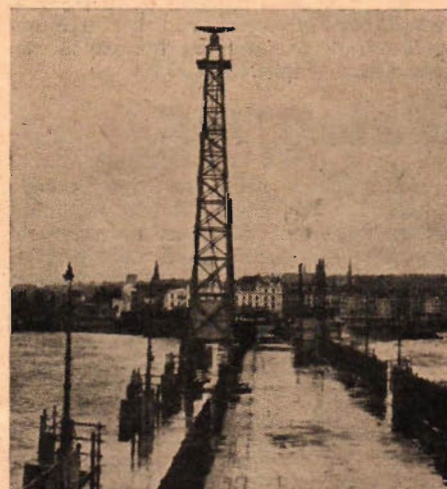
Ett intressant experiment, som ger mindre fartyg möjlighet navigera med radar rapporter från England. Bilden visar avsöknings-tornet med 10 cm-antenn i toppen.
