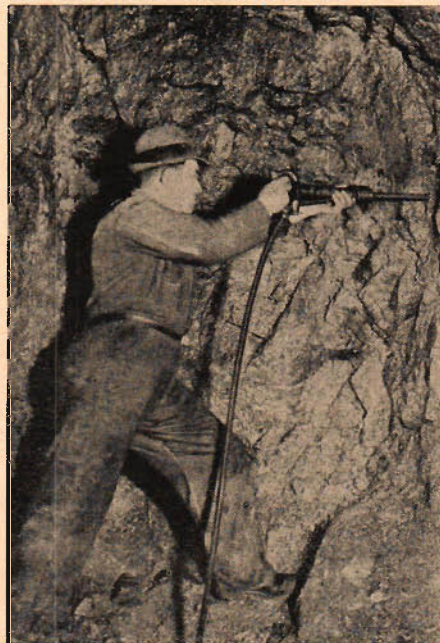
Skrotning av väggar med trycklufts-hammare.
