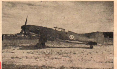
T. h. VL "PYÖRRE-MYRSKY", ensitsigt jaktplan, delvis en direkt utveckling av "Myrsky", utrustat med en 12-cylindrig radmotor av typ Daimler-Benz DB 605AC. Typen provflögs för första gången 1945. Planet byggdes emellertid endast i prototyp och någon serietillverkning kom aldrig till stånd. Toppfarten uppges till ca 630—640 km/tim.
