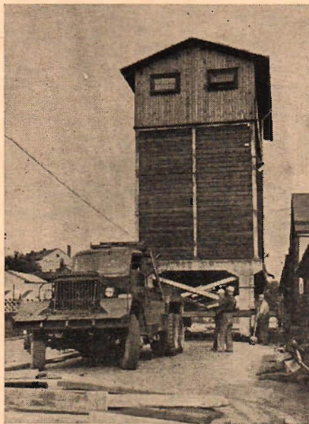
Den 14 meter höga koksfickan har börjat sin flyttning.
