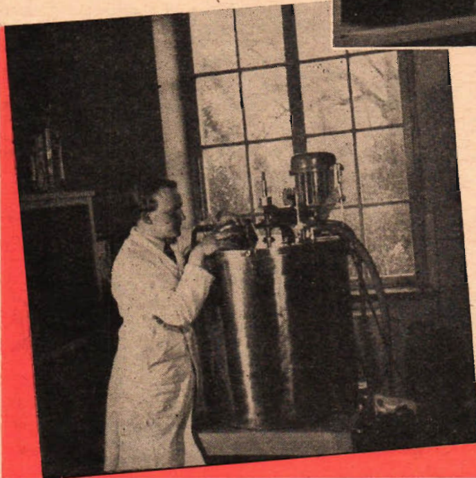
På den övre bilden kontrollerar ing. S. Zechner jästens tillväxt i laboratoriets specialkonstruerade Kluyver-kolvar.
