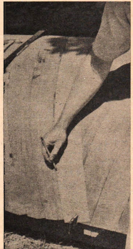
Varje lager märks för fasning exakt lika som lagret under.
