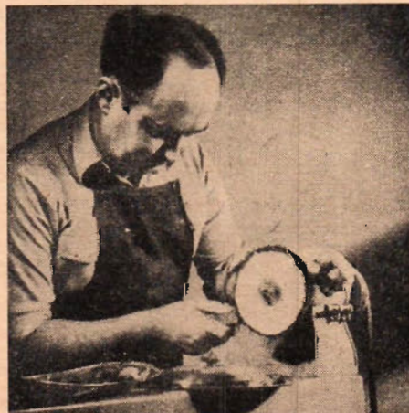
Håll paststången strax under polerskivans centrumplan. För efterpolering bör polerskivan göra 3 000 å 4 000 varv/min.
